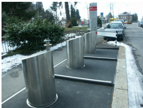
Point de collecte enterré à Berne
