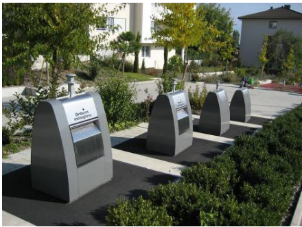
Conteneur enterré à Morges
