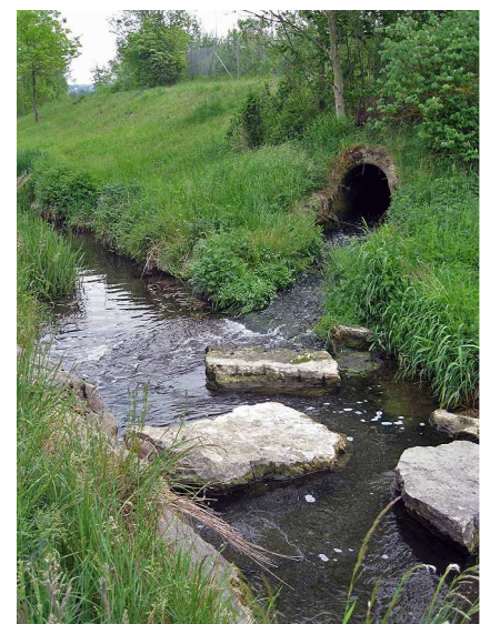
Einleitung von gereinigtem Abwasser in ein Fließgewässer: Durch gezielte Massnahmen bei ausgewählten kommunalen ARA soll der Eintrag von Mikroverunreinigungen in die Gewässer verringert werden
