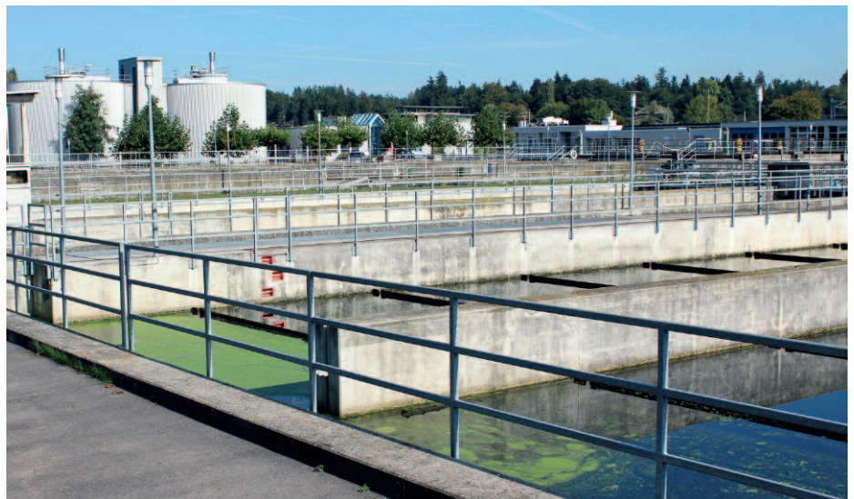
Trend zu grösseren Anlagen: In den letzten fünf Jahren sind in der Schweiz 36 meist kleinere ARA aufgehoben und an grössere Anlagen angeschlossen worden. Bild: Miryam Azer
